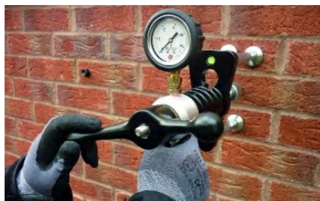
Bilde som viser strekktesting av veggutvider, med forankringstester.
