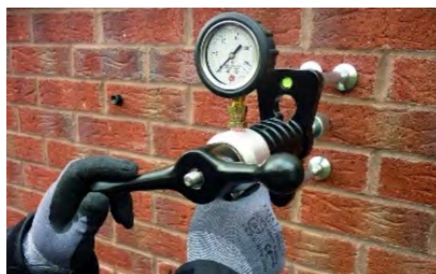
Bild som visar dragprovning av väggexpander, med en förankringsprovare.
